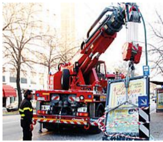
L'intervento in viale Cavour
