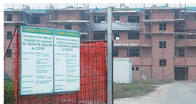
Cantieri edili: si lavora sempre meno a Ferrara e provincia (foto archivio)
